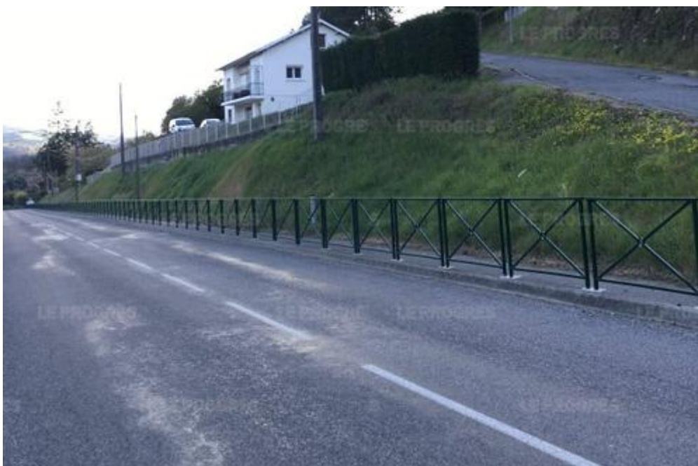
Une nouvelle demande de subvention va être déposée pour la 2 e tranche des travaux, en continuité des barrières posées. Photo Progrès /C.-Lise BOSA
